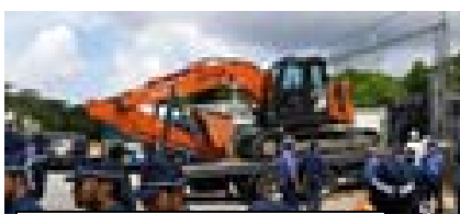
N1 ゲートから重機を搬入
