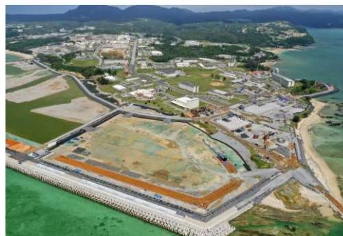
膨大な資金投入しても建設不可能な新基地
