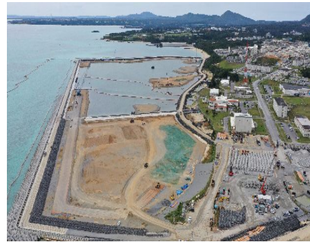
辺野古の埋め立て工事
